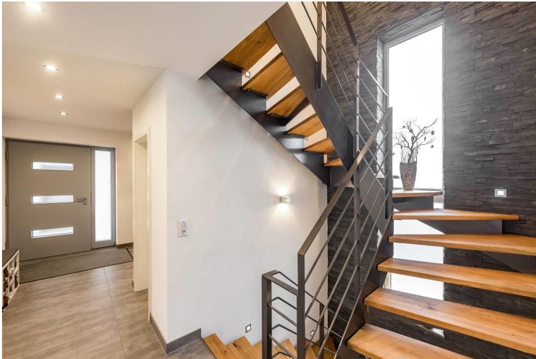
BU: Bei der Flachstahlwangentreppe begrenzen zwei sogenannte Wangen als tragende Elemente die Treppe an den Außenkanten (Fotograf: © Ingo Rack; Bild: Stadler Treppen).
